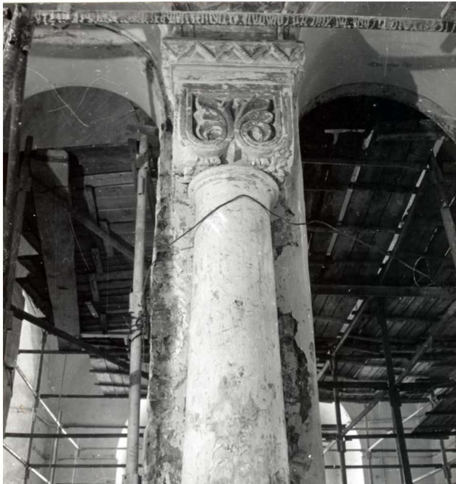
Интерьер 1-го яруса колокольни. 2-й этаж. Капитель колонны.
