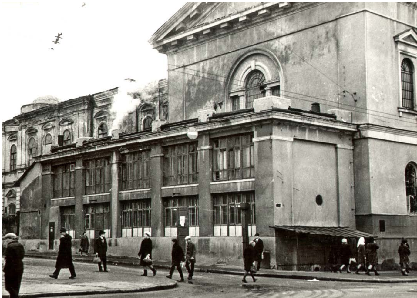
Пристройка к северному фасаду. Общий вид.
