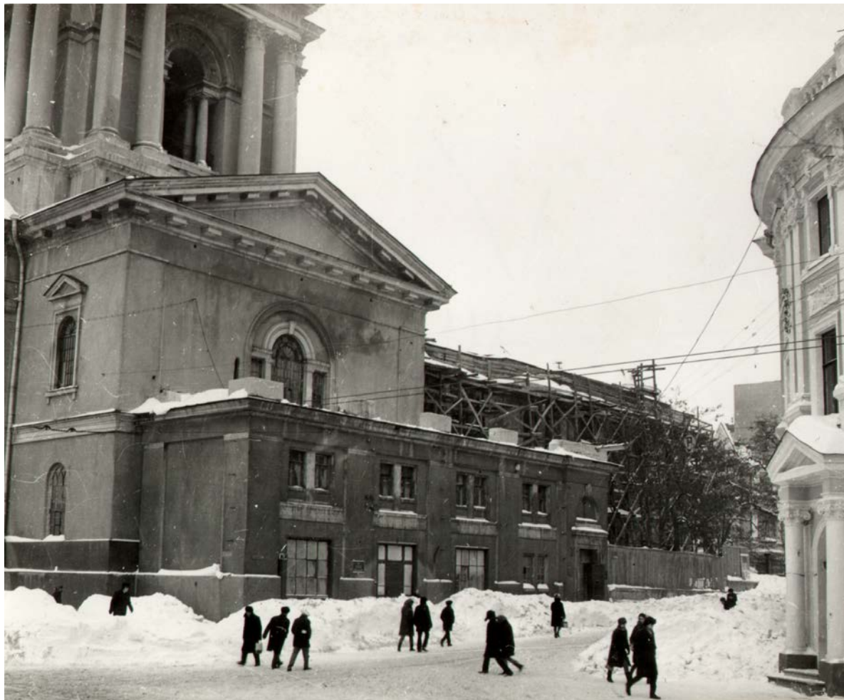
1-й ярус. Общий вид южного фасада.
