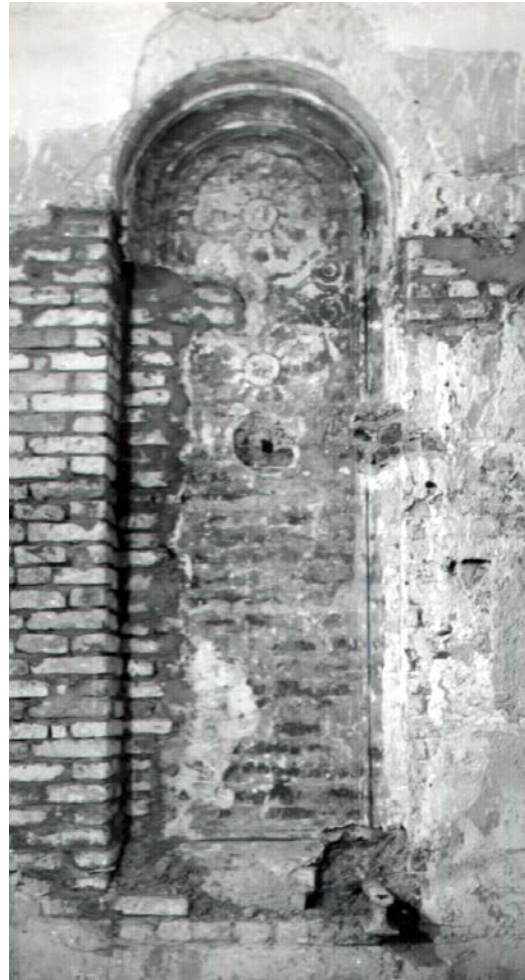
Фрагмент интерьера 1-го яруса колокольни. 2-й этаж. Роспись ниши южного крыла. Вид со стороны перехода.
