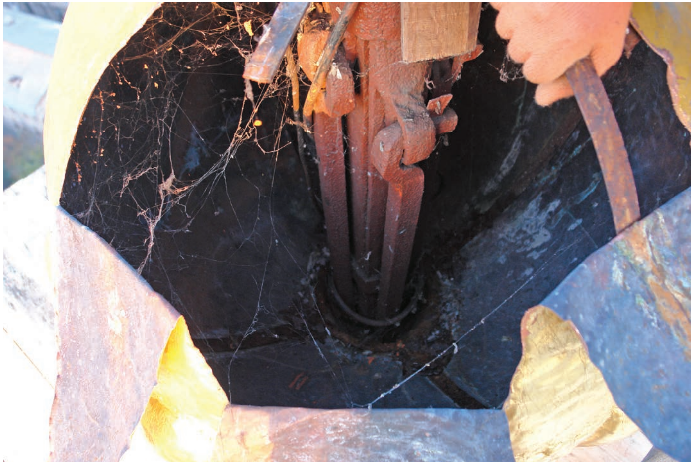
Крепление креста на колокольне Успенского собора, фото 2006 г.
