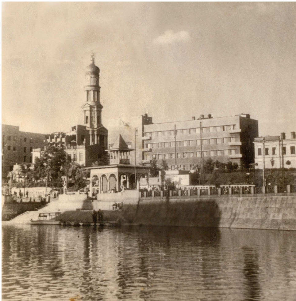
Вид на Александровскую колокольню со стороны реки Лопани, фото 1960-е годы.
