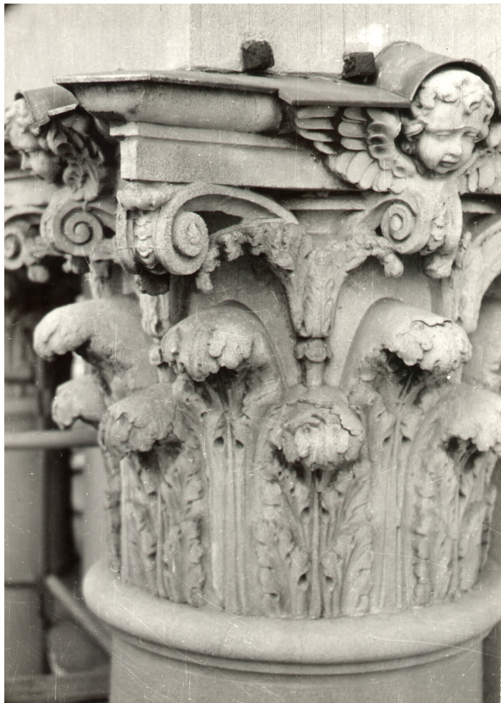
Восточный фасад. Капитель портика 3-го яруса.
