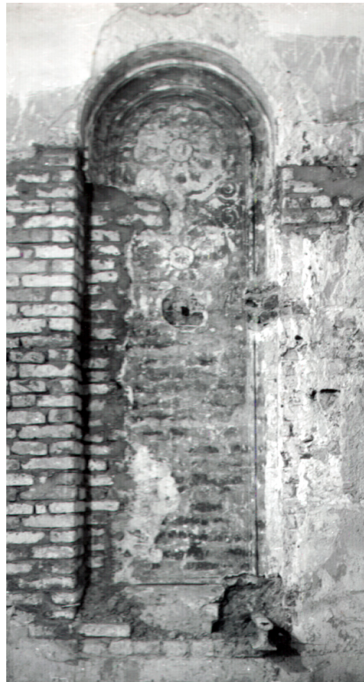
Фрагмент интерьера 1-го яруса колокольни. 2-й этаж. Роспись ниши южного крыла. Вид со стороны перехода.
