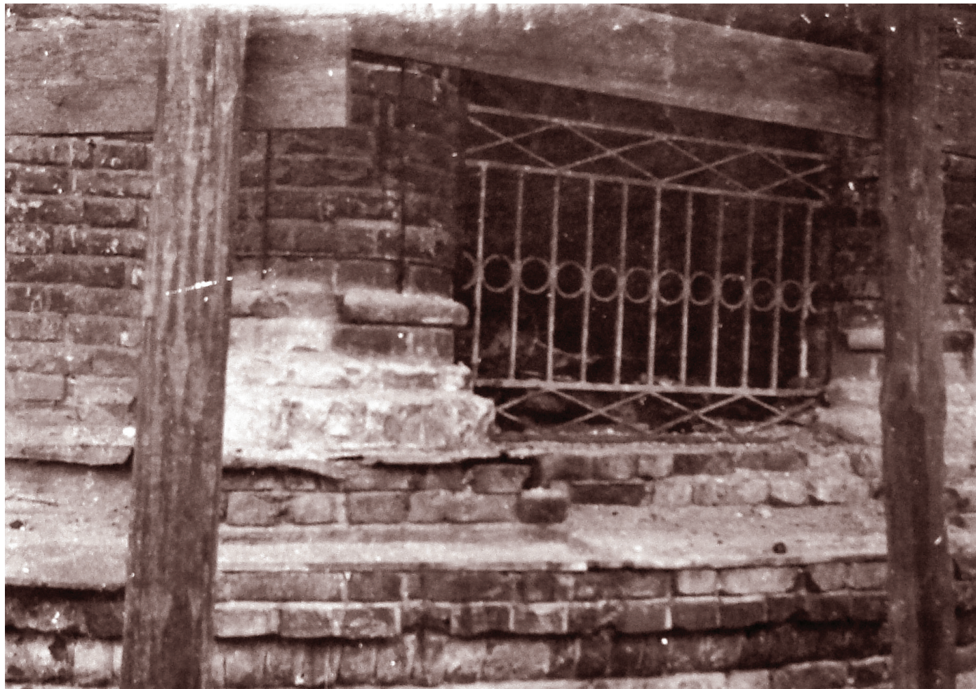
Деталь Александровской колокольни во время ремонта, фото С. Таранушенко, 1932 г.
