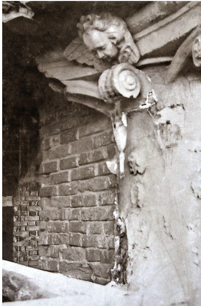
Капитель колонны Александровской колокольни во время ремонта, фото С. Таранушенко, 1932 г.
