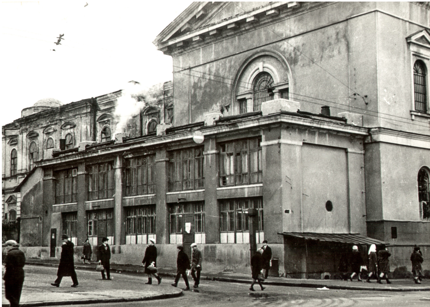
Пристройка к северному фасаду. Общий вид.
