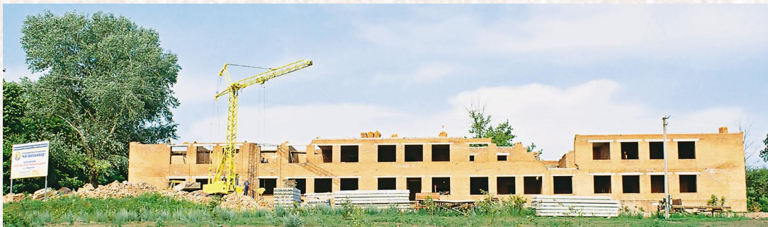
с. Хоружівка. Будується новий культурно-розважальний центр.
