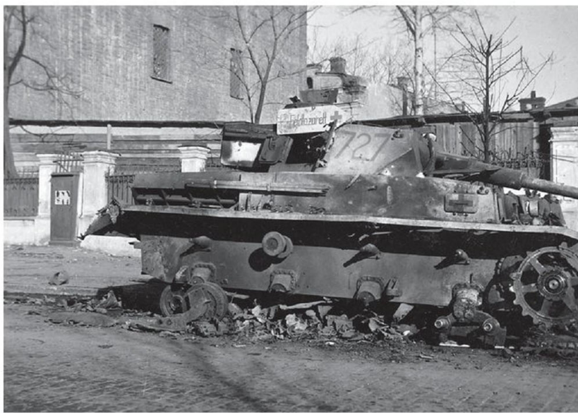
▼ Deux vues de l'épave du Panzer IV Ausf. F2 ou G n° 727 de la 7./SS-Panzer-Regiment « Leibstandarte SS Adolf Hitler » gisant dans une rue de Bielgorod et qui sert désormais de panneau routier indiquant le chemin de l'hôpital de campagne divisionnaire. Archives Caractère
